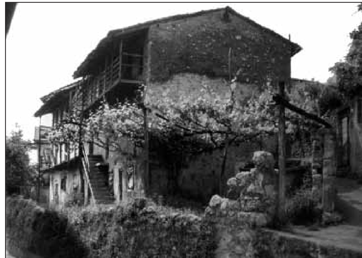
Edificio 3a), particolare del piano terra della porzione aggiunta nei primi decenni del Novecento
