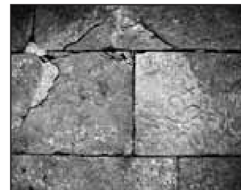
Edificio 2c), la pavimentazione originaria della corte in lastre di pietra di Sarnico
