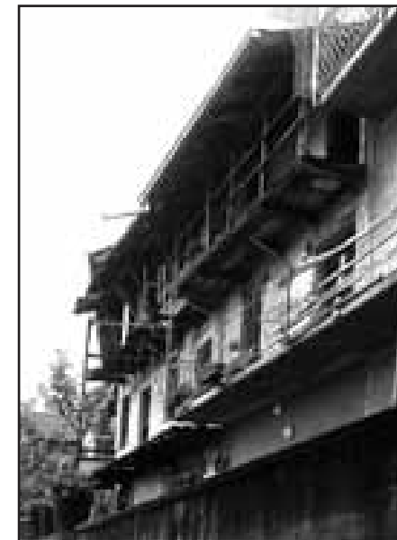
Contrada di via Castello, il prospetto meridionale del complesso edilizio 3a) con le strutture lignee ancora parzialmente conservate
