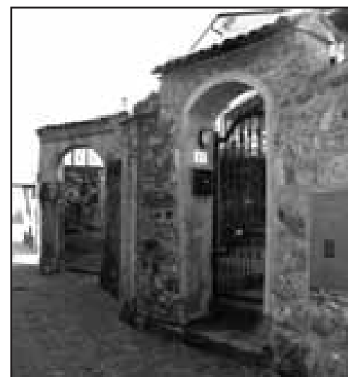
Contrada del Castello, il prospetto nord dell'edificio 4a)
