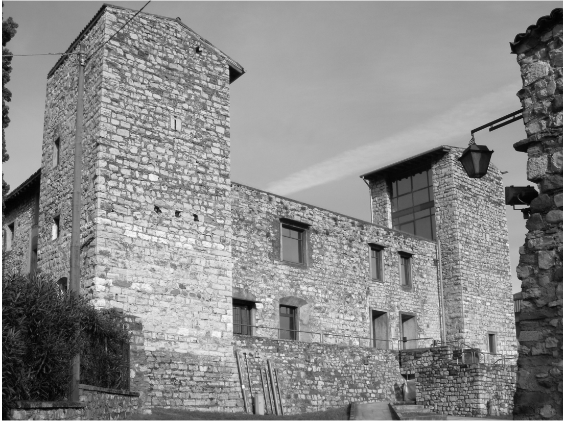
Fig. 7: Il prospetto E.
